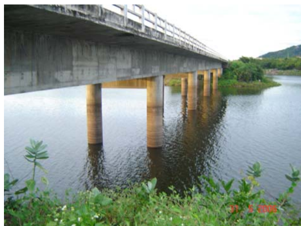
FOTO 17: Ponte rodoviária (CE 257) sobre o açude Edson Queiroz
