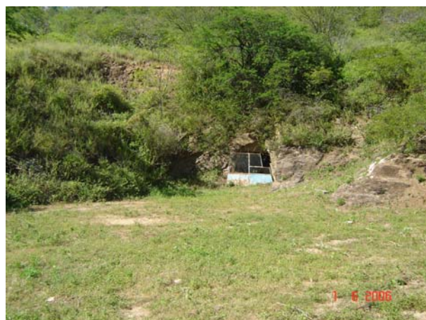
FOTO 21: Vista de uma galeria subterrânea existente na área da jazida do minério colofanito
