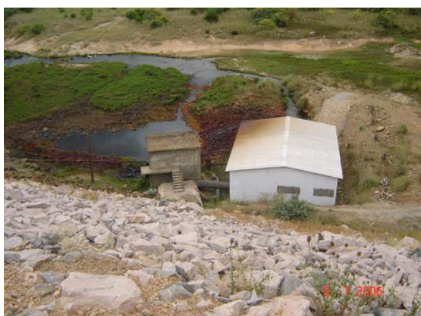
FOTO 15: Tomada d'água do açude Edson Queiroz
