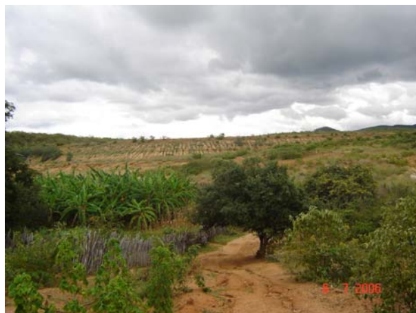
FOTO 4: Vista panorâmica da barragem do açude Gangorra
